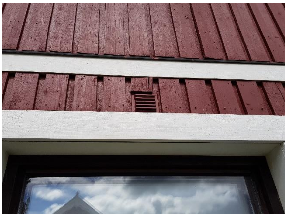
Söderfasad torr panel. Spikar slås in och bättringsmålas skadad panel byts.
