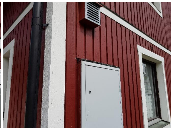
Söderfasad torr panel. Spikar slås in och bättringsmålas skadad panel byts.
