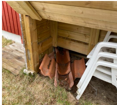
M7BD Buskar och gräs för nära fasad/altan och trasig altantrappa avrinning omöjlig i motlut stuprör kompletteras med "strumpor" som leder bort vatten från huset
