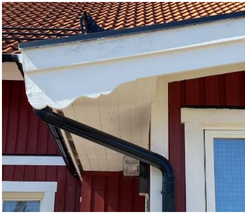
Vindskena på entré till byggnad fasad- tvättas och målas vid behov
