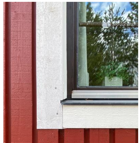
Fönsterfoder färdigmålas M2B
