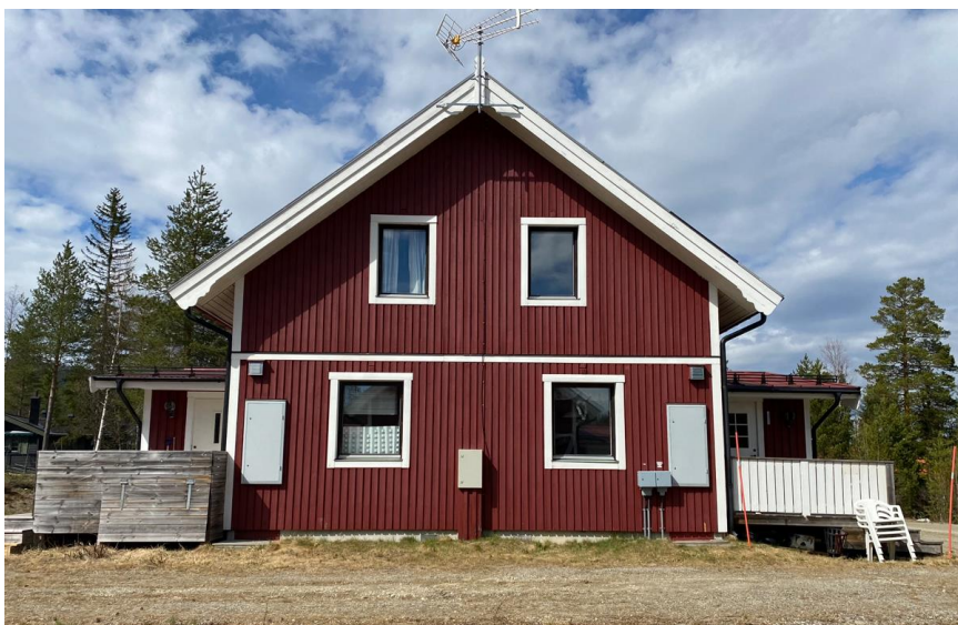
M7BA Kabelskåp för kabel-TV bränd inklädnad rötskadad. Skåp och bränd inklädnad kan rivas, då kabel-TV-installationen ej längre är i bruk. M7A Räcke åtgärdas av medlem.
